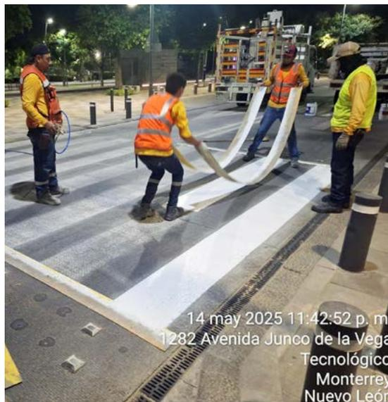
◀ Renovación de señalética horizontal y vertical en calles Junco de la Vega, Fernando García Roel, Rotonda y Ave. Del Estado. Incluye la **instalación de 2 semáforos peatonales y 10 semáforos vehiculares de 3 secciones**.
